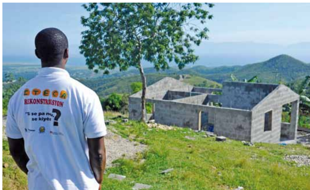
En créole sur le tee-shirt : «Reconstruction : si ce n'est pas nous, qui le fera ?» Programme de construction de cinquante maisons par Iteca (Institut de technologie et d'animation) dans le village de Chendan en Haïti. Maisons antisismiques, anti-ouragan, équipées de citernes de récupération des eaux de pluie de mille galons (3 700 litres) et de latrines. Projet soutenu par le CCFD-Terre Solidaire (mai 2013).
